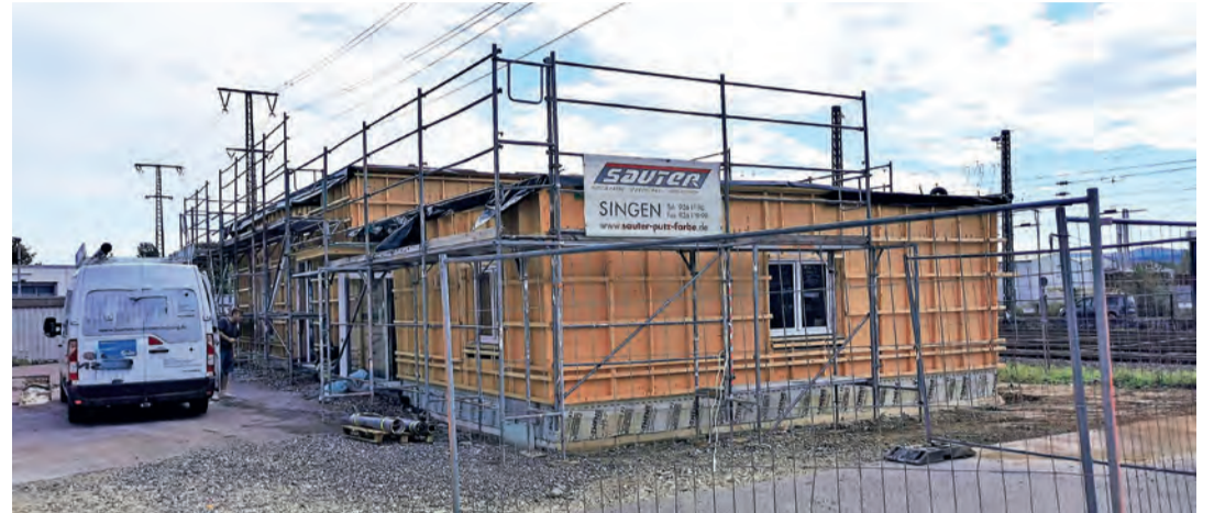
Noch ist die „neue Teestube“ hinter dem Parkhaus am Gleis unübersehbar Baustelle. Die Fassade wartet seit Wochen auf die Platten zum Abschluss.
