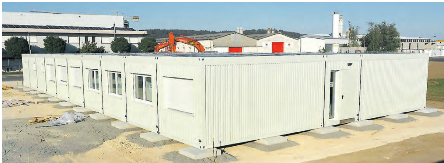
Innerhalb weniger Stunden wurde das Erdgeschoss der neuen Flüchtlingsunterkunft gesetzt.
