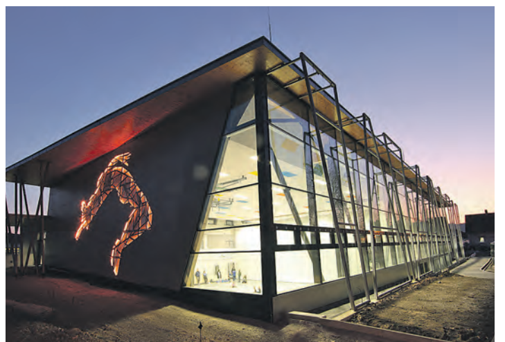
Dynamik und Transparenz spiegeln sich in der eigenwilligen Gestaltung der neuen Sporthalle wider. Die Installation an der Anne Frank Sporthalle wurde von Mansa Sabbaghian entworfen. swb-Bild: Ute Mucha
