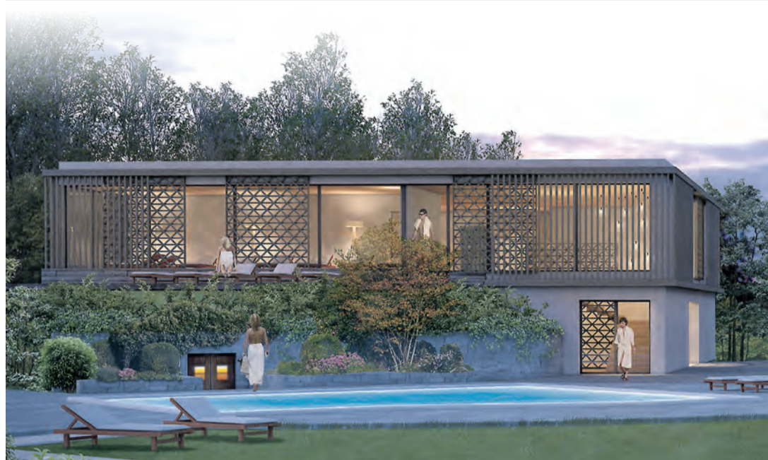
Das neue Wellnesshaus der Bora Sauna Radolfzell bietet den Gästen viele neue, hochwertig gestaltete Wellnessmöglichkeiten. swb-Bild: Bora Sauna-Bodensee
