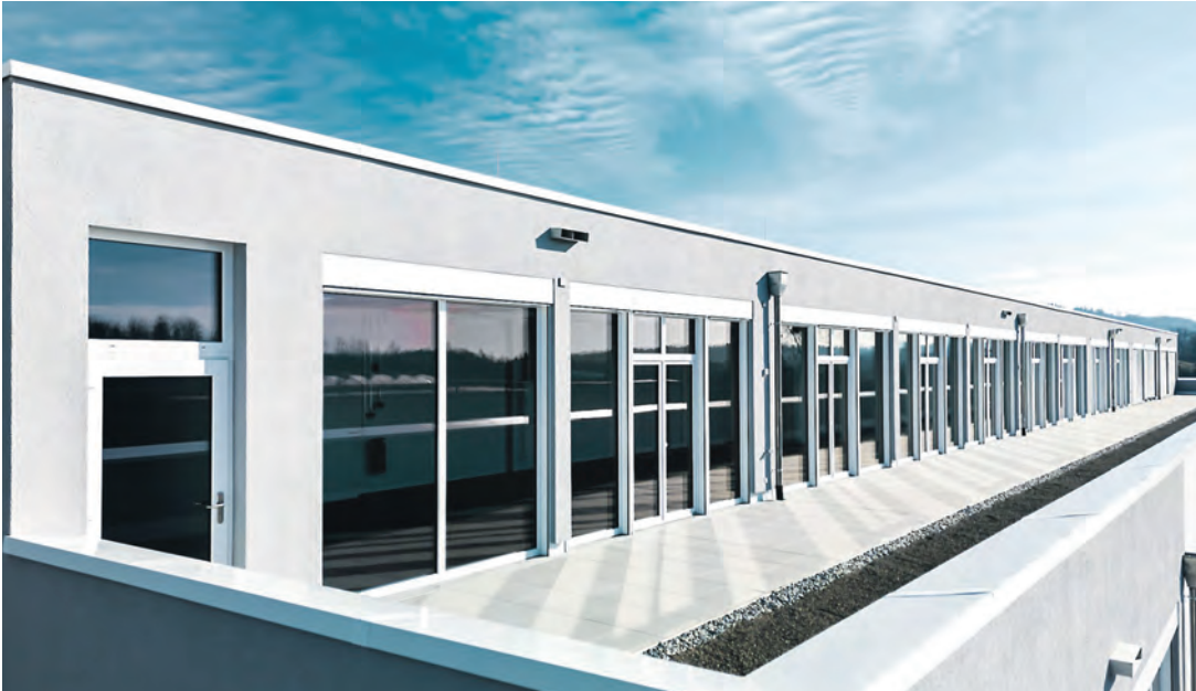
Das Grundstück wurde mit modularer Bauweise optimal genutzt. Der »Team PLACE« hat vier Stockwerke von der Tiefgarage bis zu den Büros im »Penthouse Stil«.
