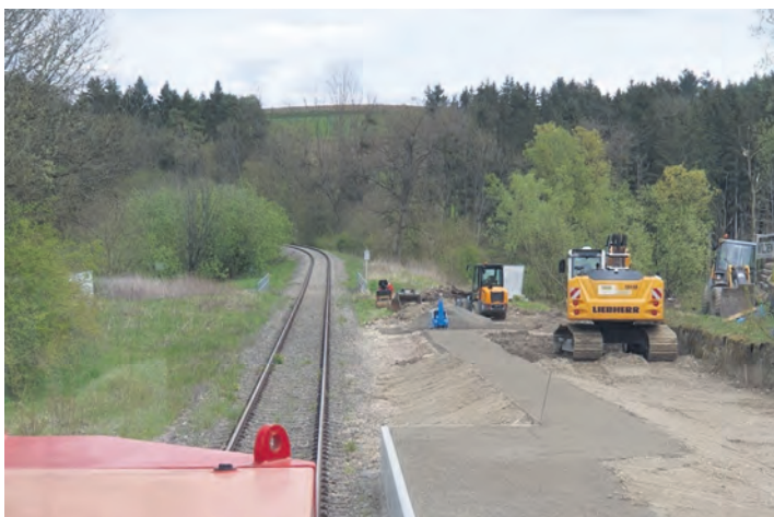
In den letzten Wochen wurde der Bahnsteig und der Zuweg zum Haltepunkt Zoznegg saniert und auf das erforderliche Niveau gebracht. Nun wird am 1. Mai, der ersten Zug der Biberbahn nach Fahrplan halten. swb-Bild: Severin Rommeler/Förderverein Biberbahn
