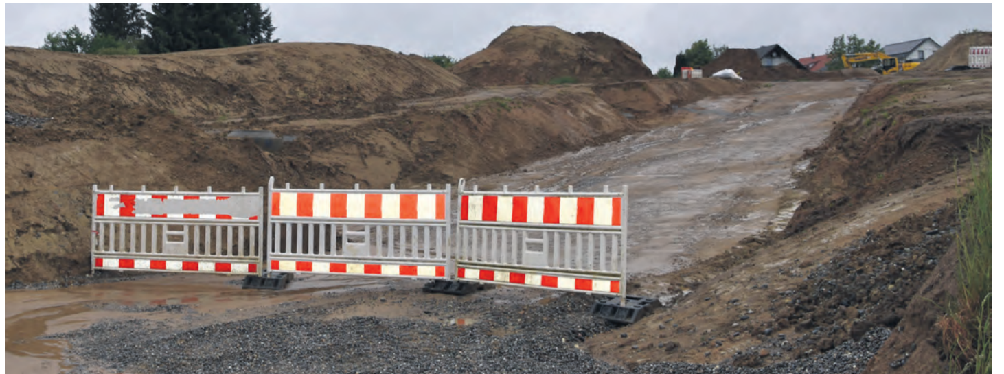
Für das Baugebiet Röschberg Süd fand im Dezember 2023 der Spatenstich statt.
