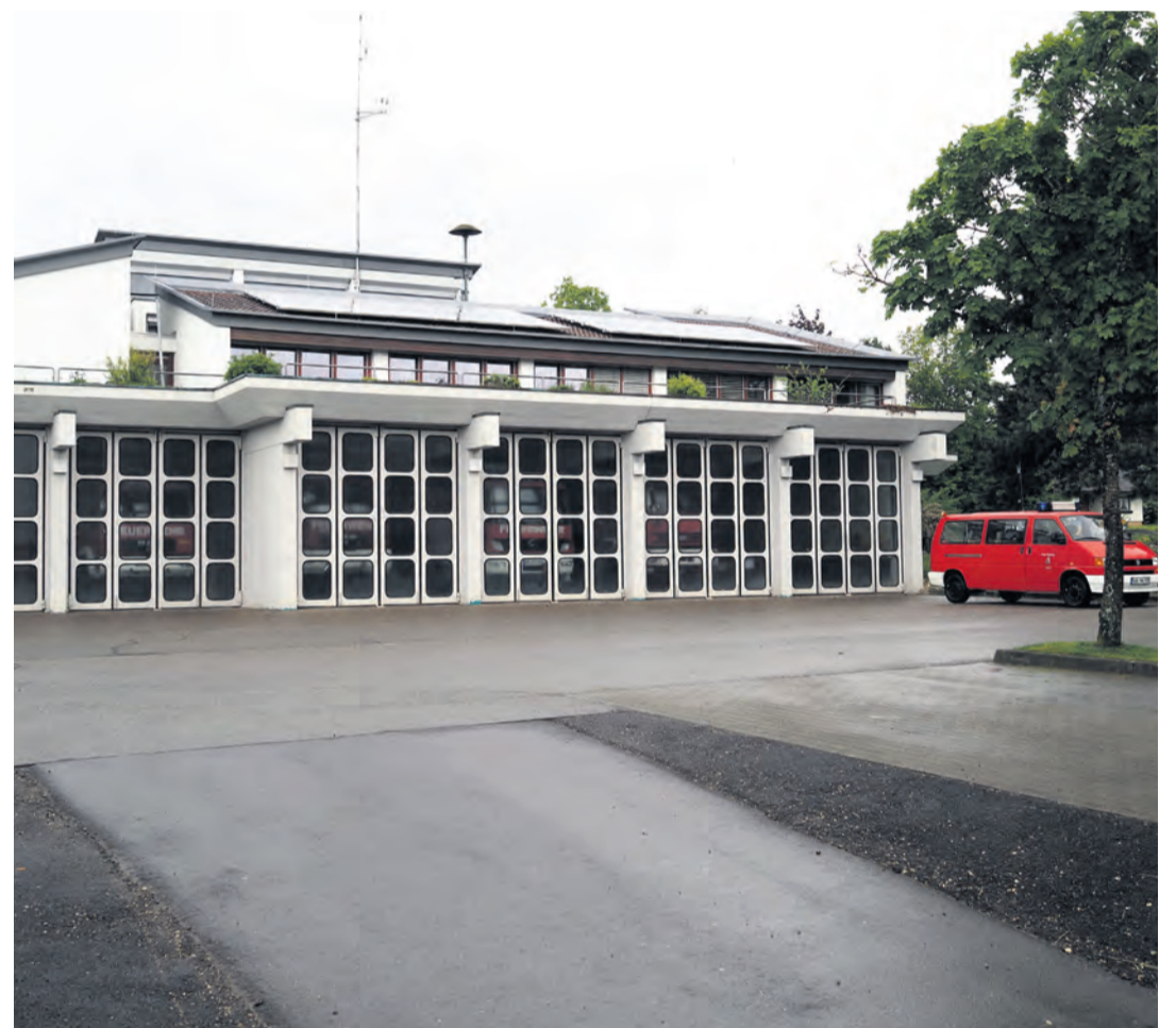
Die Zukunft des einst unter dem Rathaus erbauten Feuerwehrdepots ist eine der Schlüsselfragen für Tengens Zukunft, das nun finanziell auf für Tengen finanziell bewältigbare Beine gestellt werden muss. Fiedler
