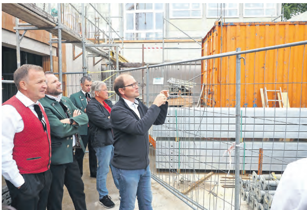
Im Rohbau der neuen Tudoburghalle in Honstetten konnte Architekt Alexander Stemmer beim Dorffest über den aktuellen Stand der Bauarbeiten informieren. Das interessierte die Mitglieder des Musikvereins besonders, die auch schon die künftige Bühnenfläche besichtigen konnten. swb-Bild: Oliver Fiedler
