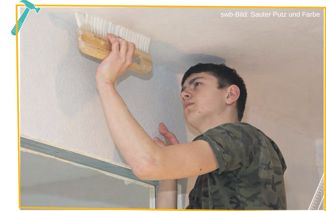
Der Ruf handwerklicher Berufe „dreckig“ zu sein, ist hinlänglich bekannt. Viele, die in diesem Bereich arbeiten, verbinden damit auch sehr positive Dinge, sind stolz darauf und glücklich dadurch.
