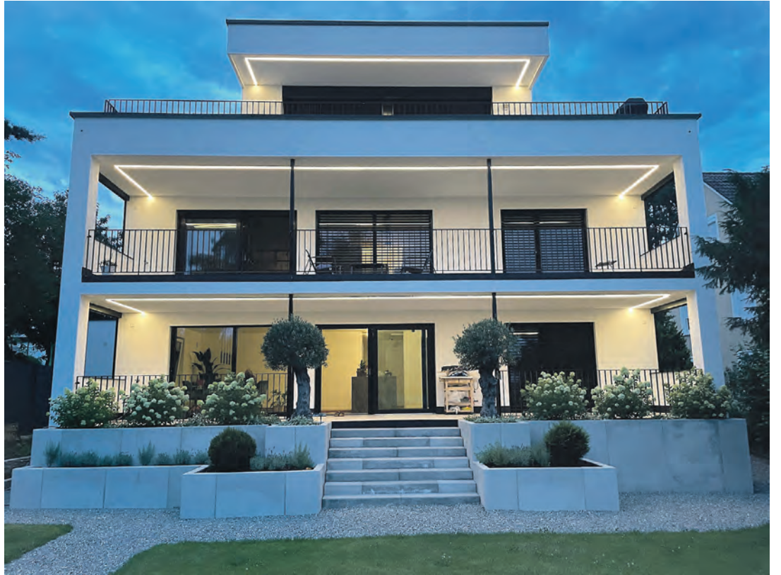
Am Abend verstärkt die LED-Beleuchtung auch hier die Wirkung des Gebäudes zum Garten hin. swb-Bild: H&B Wohnbau
