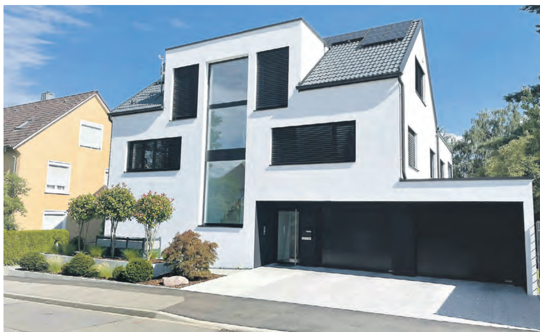
Mit ganz klarer Formen und Farbsprache setzt der Neubau der »HB Wohnbau« aus Singen im alten Baugebiet Reckholderbühl einen exklusiven Akzent. swb-Bild: Bild bearbeitet von Wezstein-Architektur
