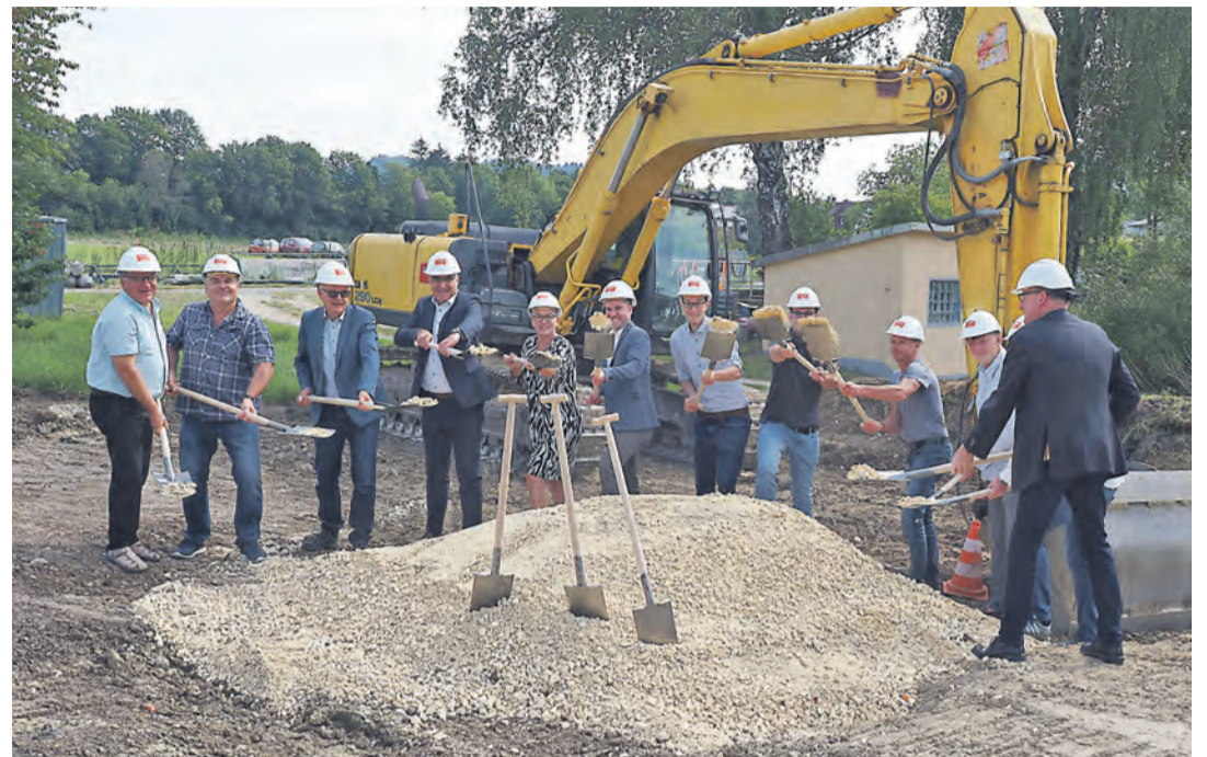
Gemeinsam mit den Bauunternehmen sowie den Vertretern der Bank konnte nun doch noch im Sommer der Spatenstich für die Erweiterung des Hilzinger Nahwärmennetzes am Freitag vollzogen werden. swb-Bild Oliver Fiedler
