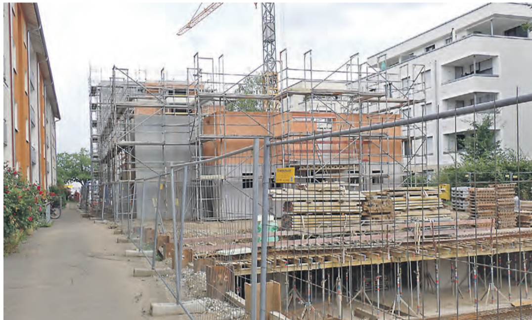
Wenn Baugenossenschaften derzeit noch bauen, geschieht das fast durchweg als Nachverdichtung, wie hier durch die Baugenossenschaft Familienheim Bodensee am Malvenweg in Singen. Grundstückskosten würden die Investitionen nochmals in unermessliche Höhen treiben. swb-Bild: Oliver Fiedler
