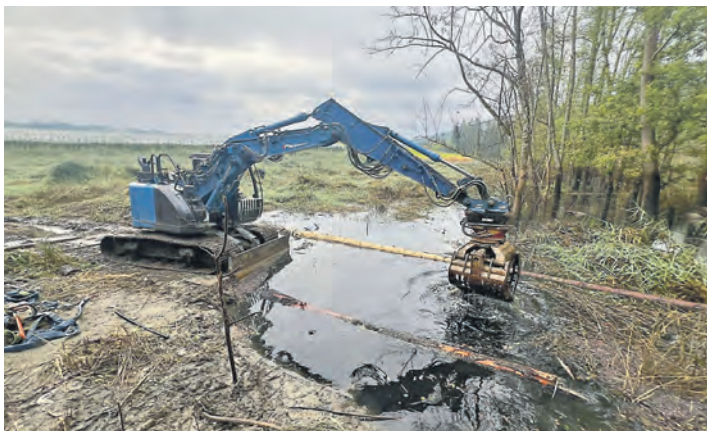
Ein Fichtenstamm wurde am Schluss der Pumpaktion dazu genutzt, den Abfluss frei zu stochern. Schon der erste Versuch war geglückt. swb-Bild: THW Radolfzell/FFW Bodman-Ludwigshafen
