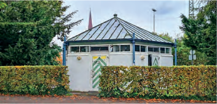
Das alte Toilettenhaus bei der Seebar, das nie für eine solche Nutzung gebaut wurde, soll nun durch einen Neubau ersetzt werden.
