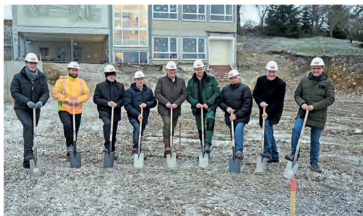
Die Beteiligten des Neubaus der Tudoburghalle konnten aufgrund des gefrorenen Bodens keinen „echten“ Spatenstich vollziehen. swb-Bild: Oliver Fiedler
