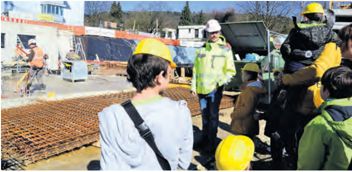
Kleine Patienten vom Kinderhaus des Hegau-Jugendwerkes konnten die Baustelle des Eltern-Kinder-Hauses besichtigen. swb-Bild: Andrea Jagode
