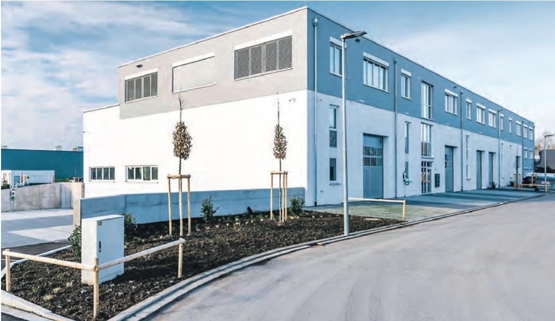
Der neue »Team PLACE« von hinten gesehen mit der Abfahrt in die Tiefgarage. Der Gewerbetrakt in Modularbauweise erlaubt Firmen, sich vor Ort zu entwickeln.
