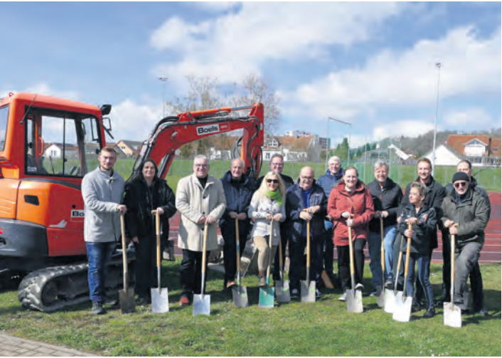
Es geht los mit der Sanierung der Leichtathletikanlage. swb-Bild: Gemeinde Rielasingen-Worblingen
