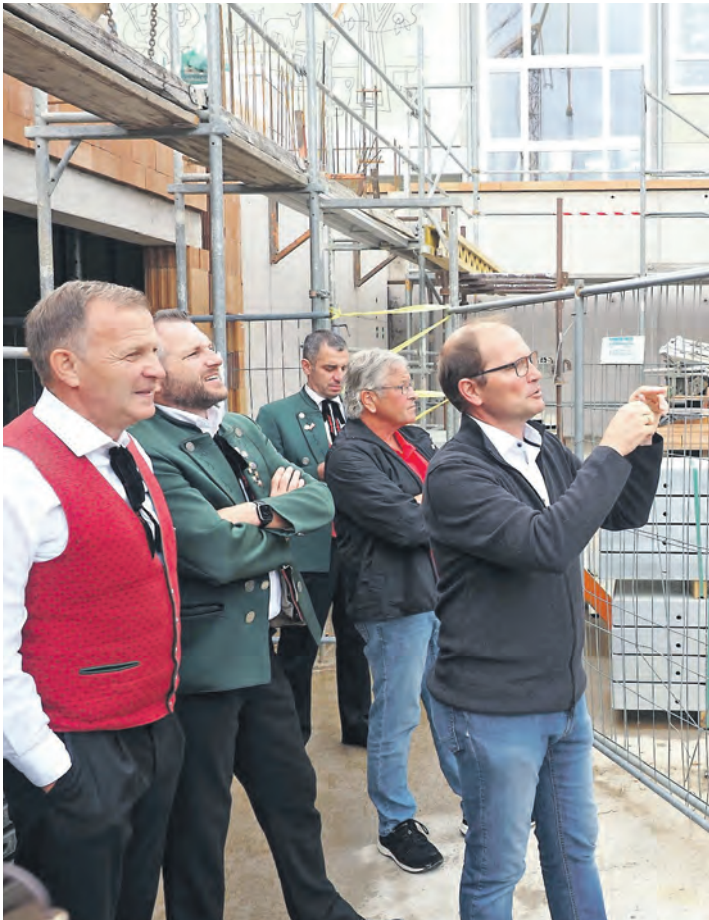
Im Rohbau der neuen Tudorburghalle in Honstetten konnte Architekt Alexander Stemmer beim Dorffest über den aktuellen Stand der Bauarbeiten informieren. Das interessierte die Mitglieder des Musikvereins besonders, die auch schon die künftige Bühnenfläche besichtigen konnten. swb-Bild: Oliver Fiedler
