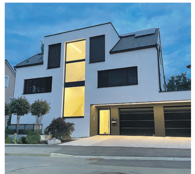
Der Neubau in der Abenddämmerung - auch hier sehr gekonnt inszeniert. swb-Bild: H&B Wohnbau
