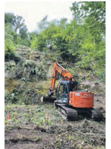
Es tut sich wieder was in der Marienschlucht. Das Unternehmen Hildebrand hat mit den Baggerarbeiten für den Zugangsturm zur Steganlage begonnen. swb-Bild: Gemeinde
