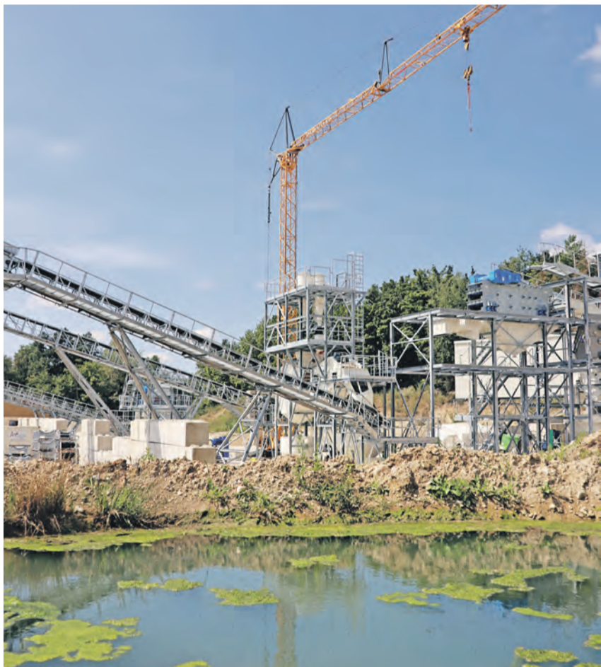
Teilansicht der entstehenden Boden- und Recycling-Waschanlage Foto: © Ludmilla Borodin, Wochenblatt
