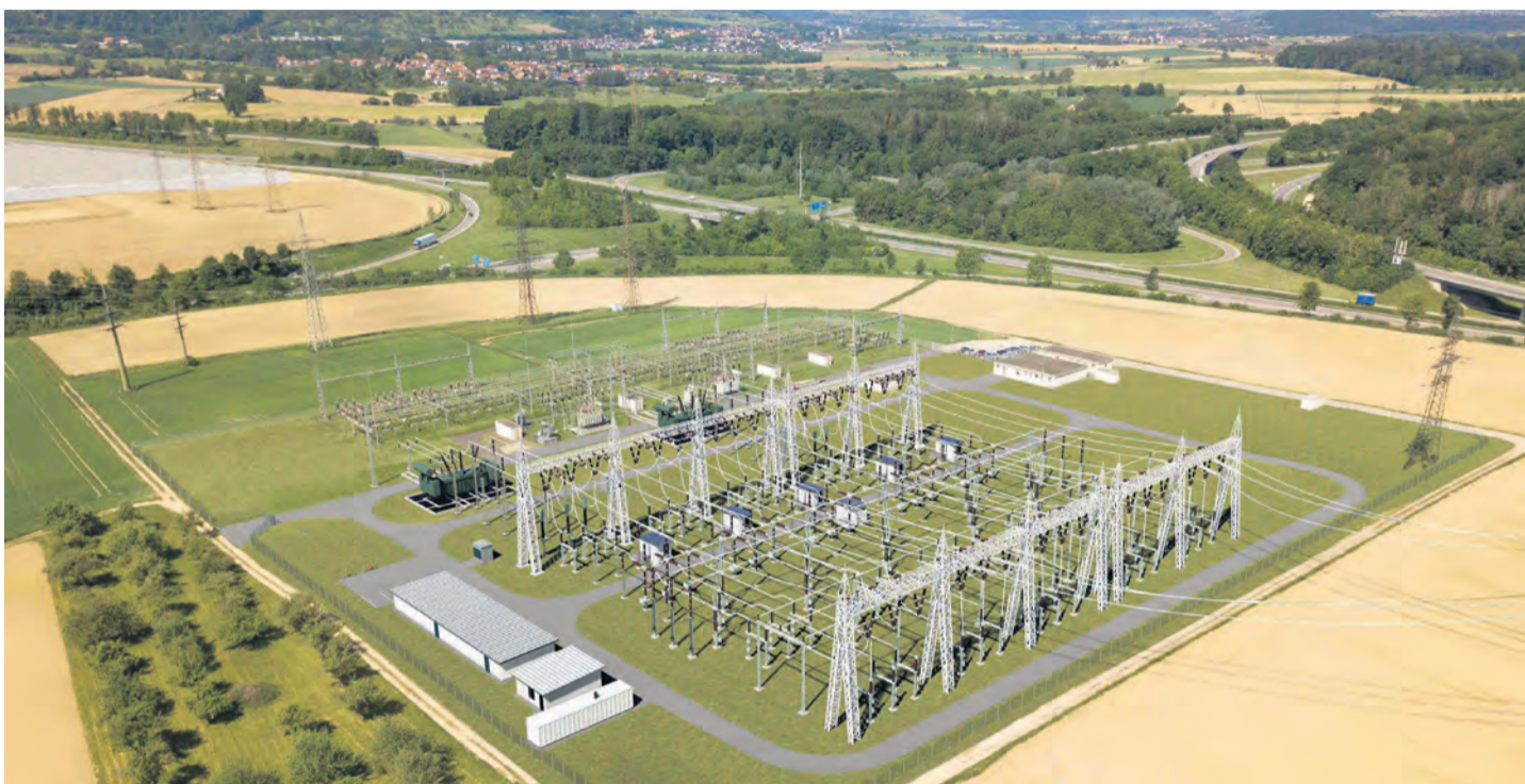
Von oben gesehen fast schon zierlich wird die Planung des neuen Umspannwerks bei Singen-Beuren der Transnet BW, das bis 2026 in Betrieb gehen soll. sub-Bild: Transnet BW
