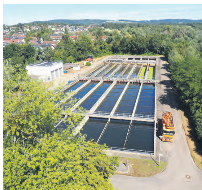
An der Radolfzeller Kläranlage soll eine neue Wärmezentrale entstehen. Dort wird auch Seewärme genutzt. Im Bild das Nachklärbecken.
