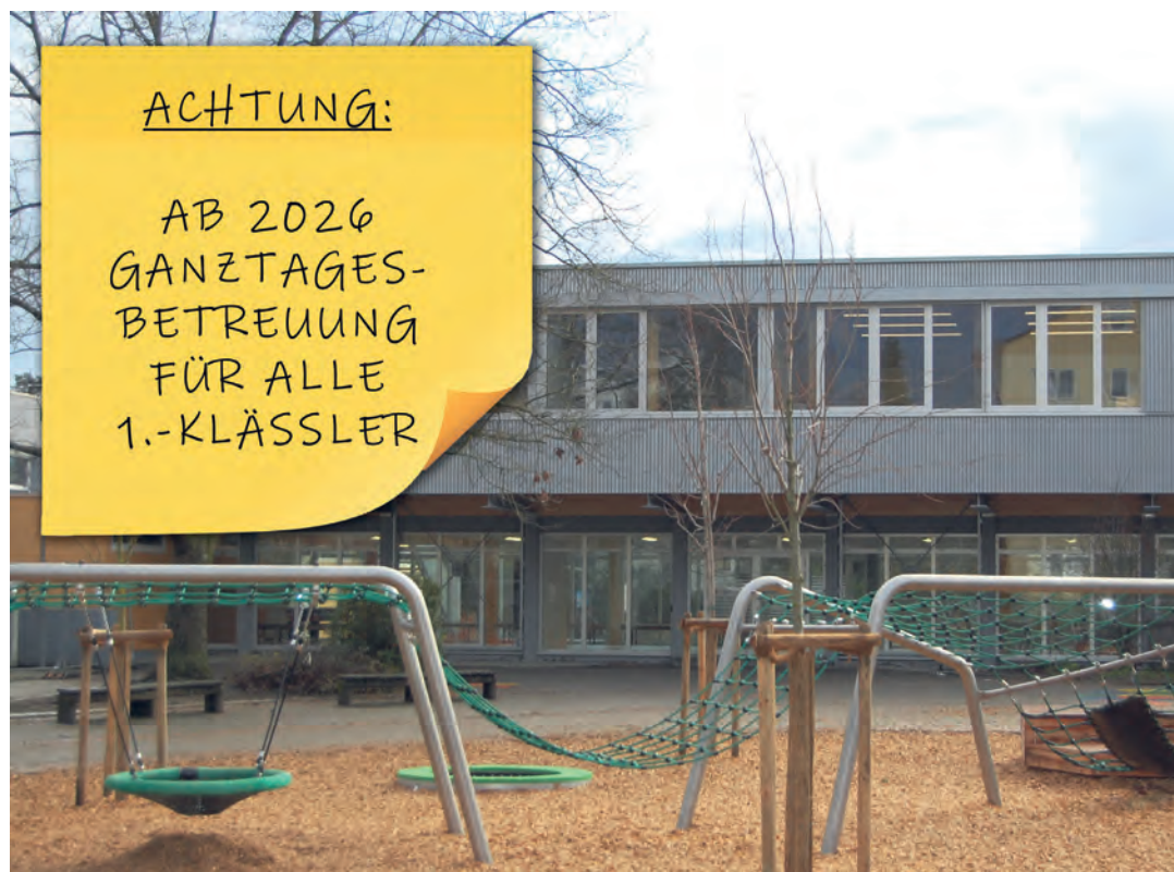
Ab August 2026 gilt für alle Erstklässler ein Anspruch auf Ganztagesbetreuung, der in den folgenden Jahren um jeweils eine Klassenstufe ausgeweitet wird. Davor stehen mancherorts aber noch einige Arbeiten an - wie beispielsweise hier in der Bruderhofschule in Singen.
