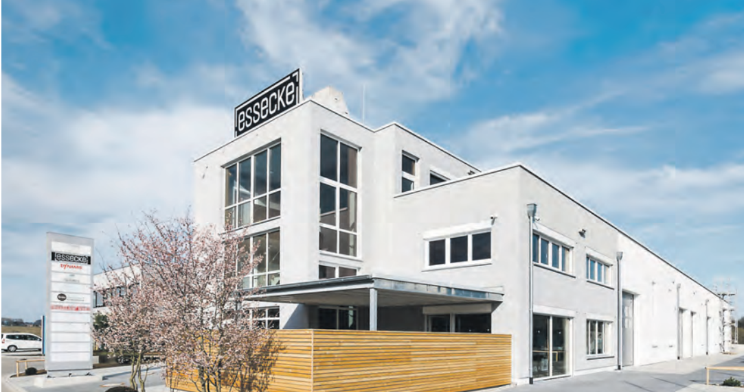
Nach nur 14 Monaten Bauzeit konnte der »Team PLACE« im Steißlinger Gewerbegebiet durch die »Teamhaus Immobilien« als Bauherr erstellt werden. Nun sind auch die Außenanlagen fertig und die »Essecke« hat eröffnet.
