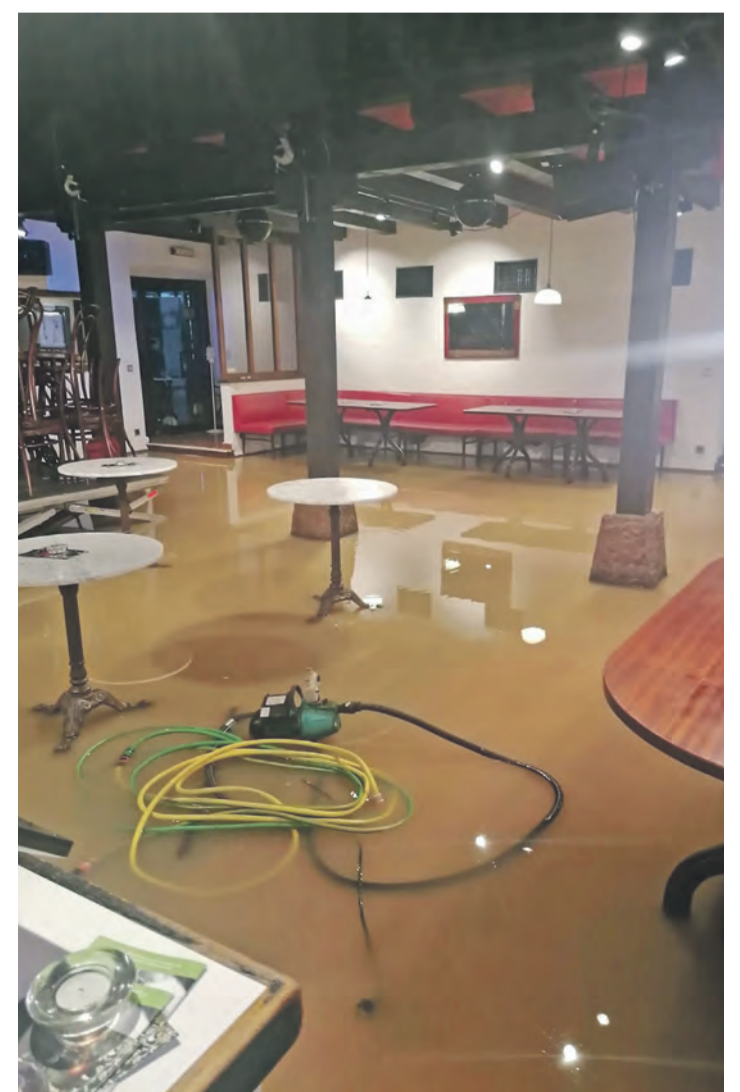
Viele Keller standen unter Wasser. Allerdings ist das hier kein Keller, sondern das Kneipentheater „Die Farbe“, das wie von einem Fluss durchspült wurde. Trotzdem stehen die Schauspieler inzwischen wieder auf der Bühne. swb-Bild: Kühling
