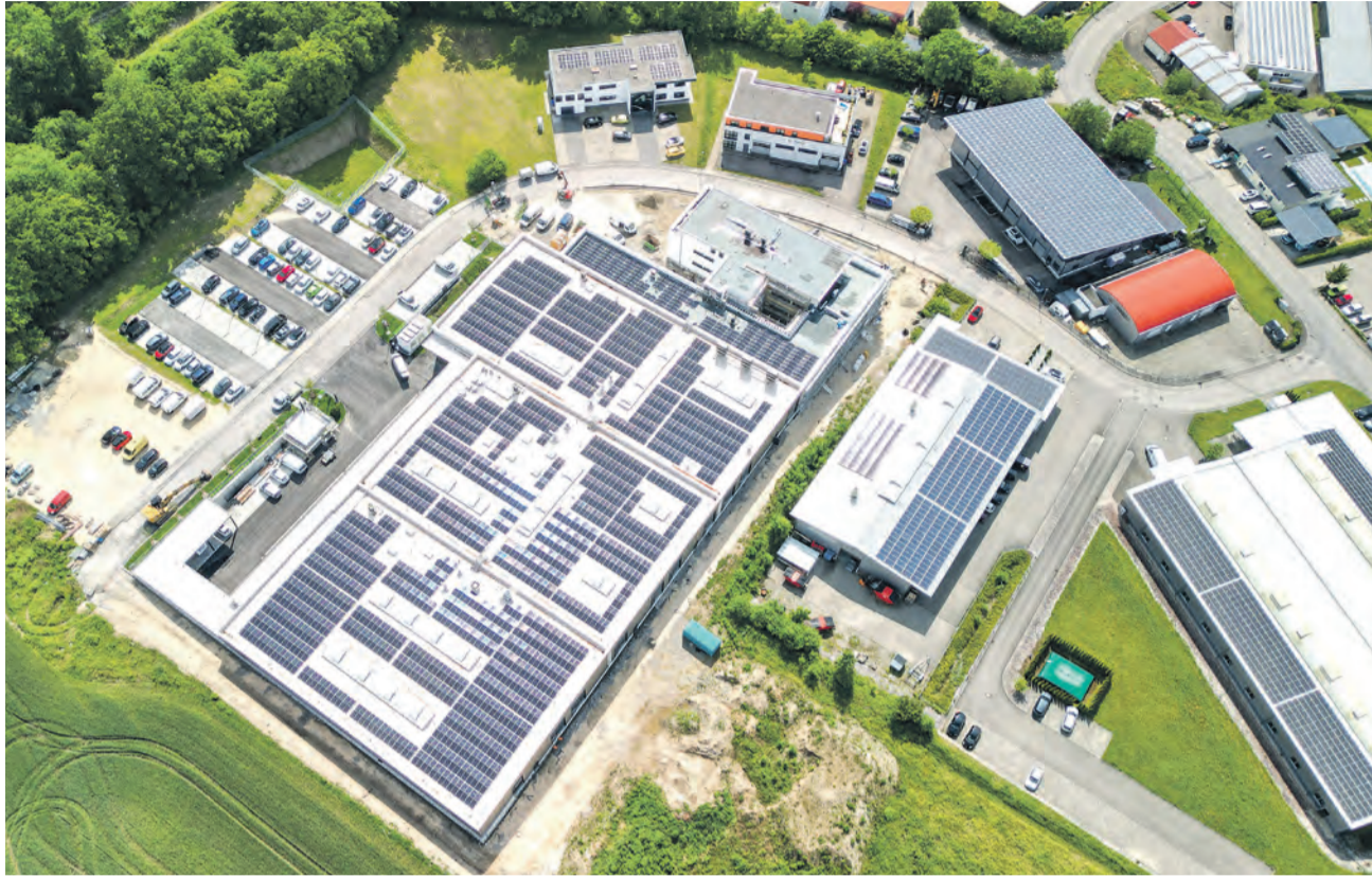
EUREGIO MEDTEC 2050 heißt die Vision und das Gebäude der Kammerer-Medical-Group. Der Bau wurde nach maximalen Standards bezüglich Nachhaltigkeit gebaut und bietet optimale Arbeitsplätze.
