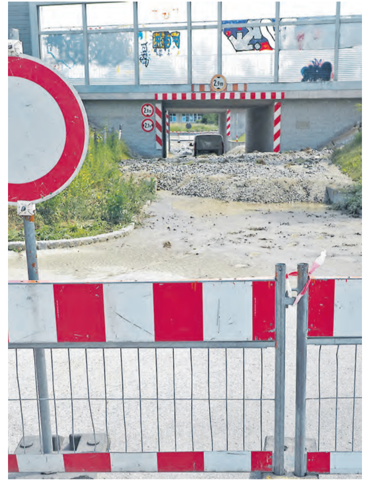
Nach einer Stunde war der Regen vorbei. Um den ganzen Schotter aus der Unterführung der Singener Schlachthausstraße herauszubekommen, ging es mehrere Tage. Das Auto darin war von beiden Seiten eingeschlossen, was auch deutlich macht, wie schnell die Flutwelle mit ihrer Schmutzfracht kam. An dieser Stelle war auch das Gleisbett der Bahn schwer beschädigt worden.
