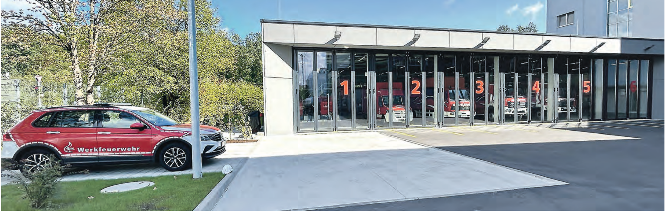
Der Neubau der Takeda-Werkfeuerwehr bietet unter anderem mit einer Atemschutzwerkstatt und den lang ersehnten Sozial- und Schulungsräumen moderne Räumlichkeiten sowie aktuelle Technik.
