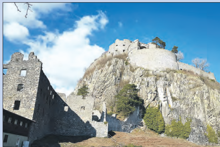
Die komplexen Baustrukturen des Hohentwiels sind bis jetzt noch nicht komplett erforscht.
