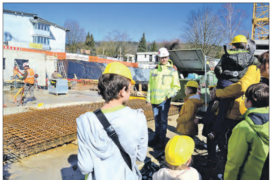
Baustellenleiter Daniel Sinner von der Firma Züblin (Bereich Bodensee) verriet der interessierten Besucherschar manch Spannendes über die Baustelle.
