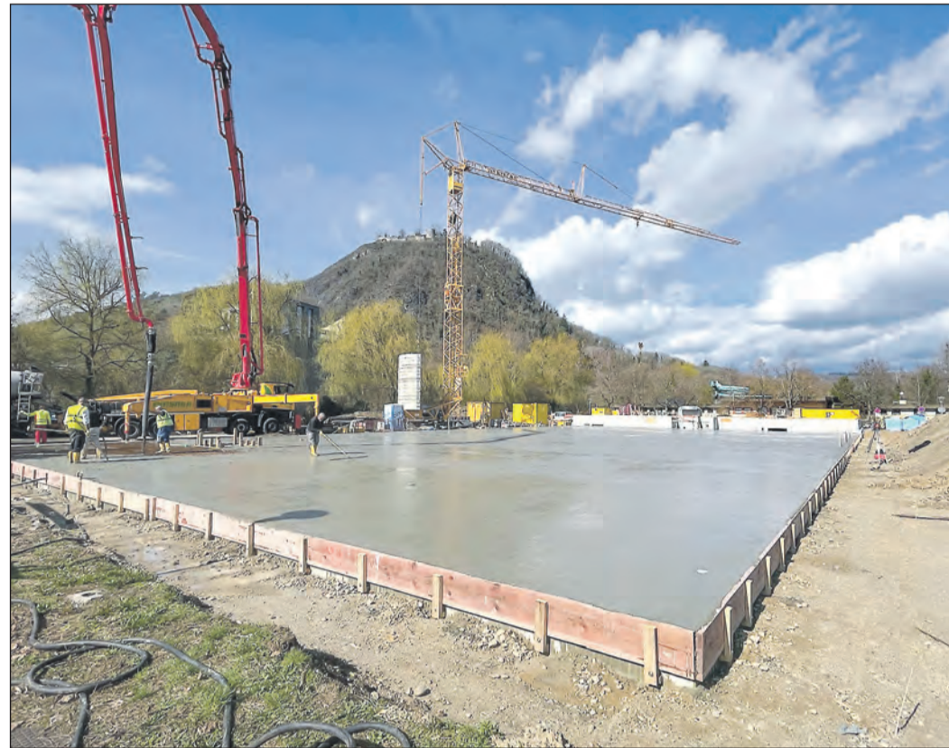
Nach dem Spatenstich im vergangenen Jahr hat die Bodenplatte der Scheffelhalle 2.0 mittlerweile Form angenommen: Aus 270 Kubikmetern recyceltem Beton wurde das 1.150 Quadratmeter große Fundament der neuen Halle gegossen. Mit diesem Meilenstein geht der Bau auch weiterhin gut voran. Die Fertigstellung der neuen Scheffelhalle ist für das zweite Quartal 2025 geplant.
