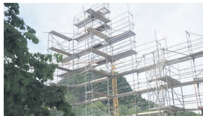
Die Kubatur der künftigen „Scheffelhalle 2.0“ zeichnet sich inzwischen durch Gerüstbauten ab. swb-Bild: Oliver Fiedler
