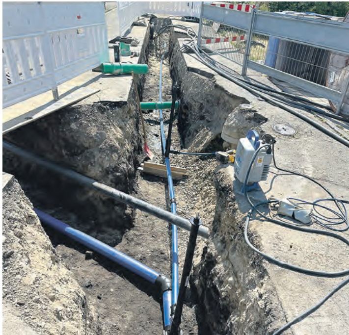
Die Erneuerung der Versorgungsleitung in der Kurt-Fahr-Straße und Walter-Diehr-Straße in Stockach. swb-Bilder: Meier Strassen- und Tiefbau
