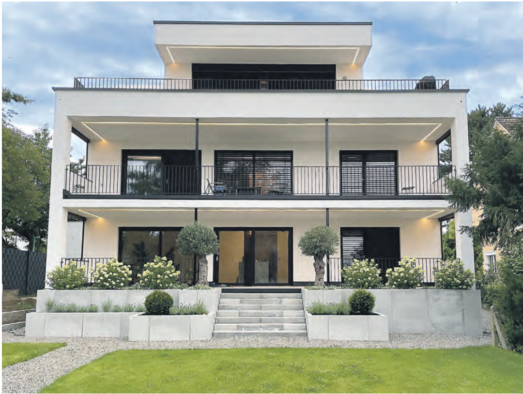
Die andere Seite des Neubaus: Mit großzügigen und szenischen Balkonen öffnet sich das Gebäude zum parkähnlichen Garten hin. swb-Bild: H&B Wohnbau
