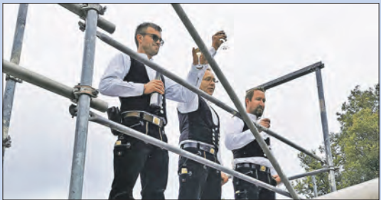
Die Zimmerleute halten den sogenannten Richtspruch.
