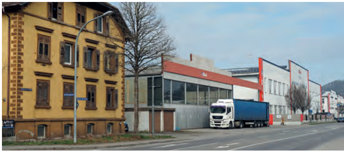
Veränderungen kündigen sich für das Rival-Areal an. Das „Gelbe Haus“ wie die ehemalige „Phönix-Halle“ sollen zwei Produktionshallen und einem Verwaltungstrakt weichen. swb-Bild: Oliver Fiedler
