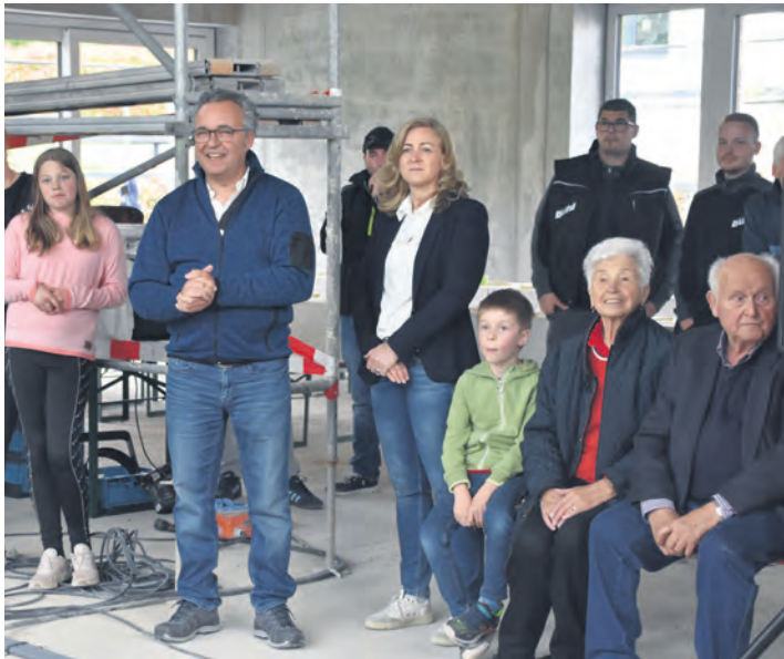
Ralf und Nicole Homburger (Mitte) freuen sich sehr, mit dem Richtfest einen weiteren Schritt in Richtung „neues Bestattungshaus“ gehen zu können. sub-Bild: Philipp Findling
