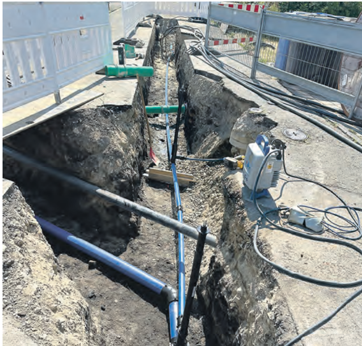
Die Erneuerung der Versorgungsleitung in der Kurt-Fahr-Strasse und Walter-Diehr-Strasse in Stockach. swb-Bilder: Meier Strassen- und Tiefbau
