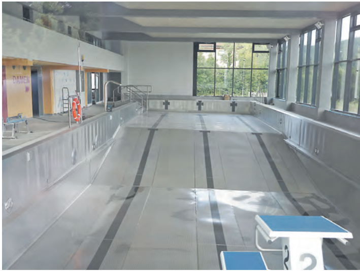
Fast fertig ist endlich die Sanierung des Stockacher Hallenbads. Zum 23. September soll es eröffnet werden können.
