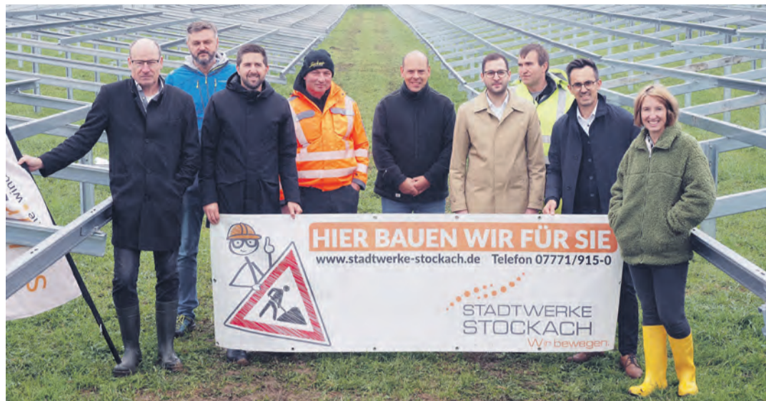
Die Beteiligten des neuen Solarparks Schorenweiher feierten nicht den Spatenstich, sondern sogar schon das Richtfest. swb-Bild: Oliver Fiedler
