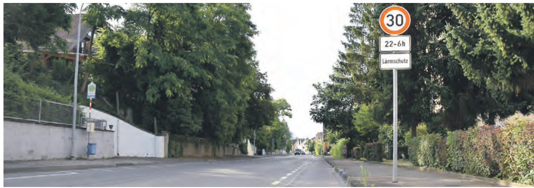
Die Baustelle bei der Hohenkrähenstraße sorgt seit Baubeginn im Herbst 2023 bei vielen Verkehrsteilnehmern weiterhin für Probleme.
