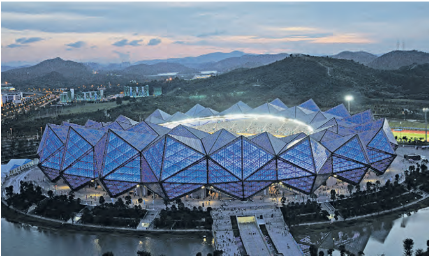
Das Stadion in Shenzhen/China, als Anwendungsbeispiel für moderne Architektur aus glasklaren Platten. Fotos: ©Breyer
