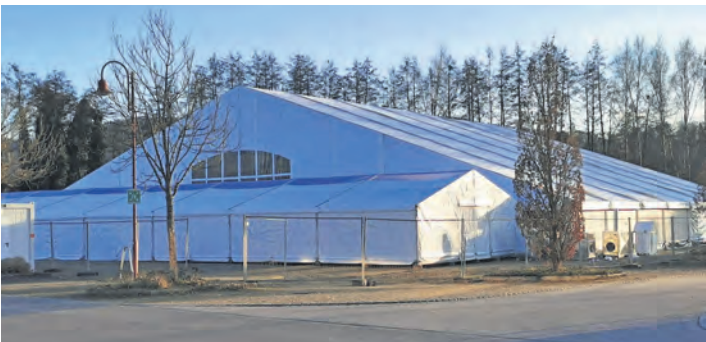
Die Leichtbauhalle in Rielasingen-Worblingen wird voraussichtlich ab Juni leer stehen. Dennoch will der Landkreis bis Ende 2025 daran festhalten.
