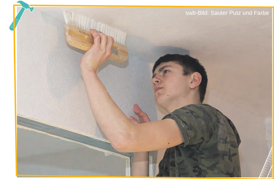
Der Ruf handwerklicher Berufe „dreckig“ zu sein, ist hinlänglich bekannt. Viele, die in diesem Bereich arbeiten, verbinden damit auch sehr positive Dinge, sind stolz darauf und glücklich dadurch.
