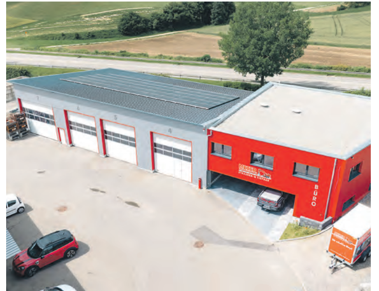
Luftbild von »Meier Straßen- und Tiefbau« im Himmelreich 5 in Stockach-Hindelslingen.
