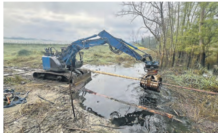
Ein Fichtenstamm wurde am Schluss der Pumpaktion dazu genutzt, den Abfluss frei zu stochnern. Schon der erste Versuch war geglückt. swb-Bild: THW Radolfzell/FFW Bodman-Ludwigshafen
