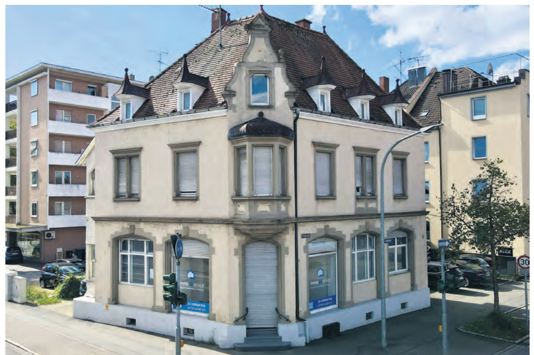
Veränderungen zum Positiven hin kündigen sich für das Wohn- und Geschäftshaus an der Ecke Freiheit-/Ringstraße an. Das Unternehmen „H&B Wohnbau“ will hier bald mit einer Sanierung des unter Denkmalschutz stehenden Gebäudes beginnen.
