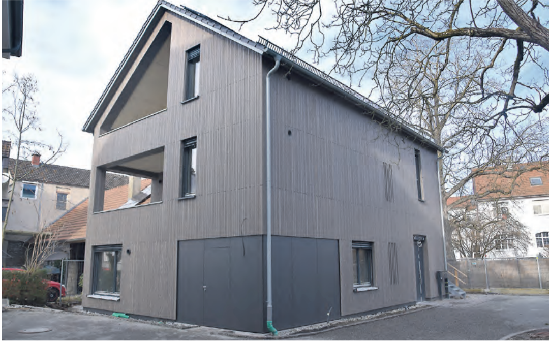
Auf insgesamt 150 Quadratmetern haben die Mieter im nachhaltig gehaltenen Holzneubau von BDS Universal-Bau die Möglichkeit zur freien Wohngestaltung.
