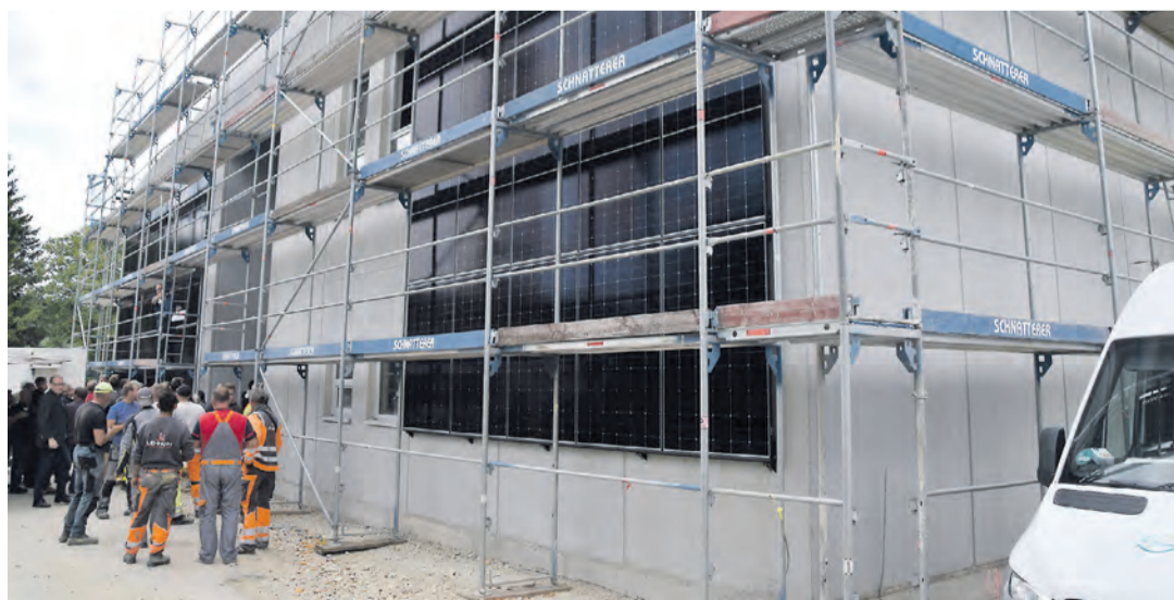
Planer, Architekten und Handwerker feierten gemeinsam das Richtfest für die Heizzentrale in Hilzingen. swb-Bild: Tobias Lange
