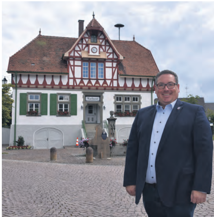
Der Mooser Bürgermeister Patrick Krauss vor dem Rathaus in Iznang, dessen umfangreiche Sanierungsarbeiten noch in diesem Herbst abgeschlossen werden sollen. swb-Bild: Philipp Findling
