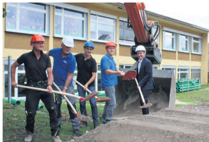
Ingo Heine (R.Britsch, von links), Matthias Baur (Baur Bauunternehmung), Andreas Ernst (Eco Architektur), Domenik Mayer (Bauamt) und Bürgermeister Holger Mayer beim Spatenstich für die Grundschulerweiterung.
