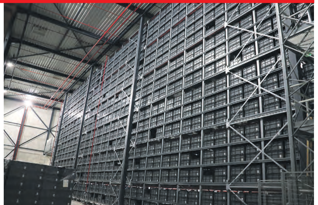
Die erste umgesetzte Gasse im Shuttle-Lager bietet Platz für bis zu 10.800 Behälter.
