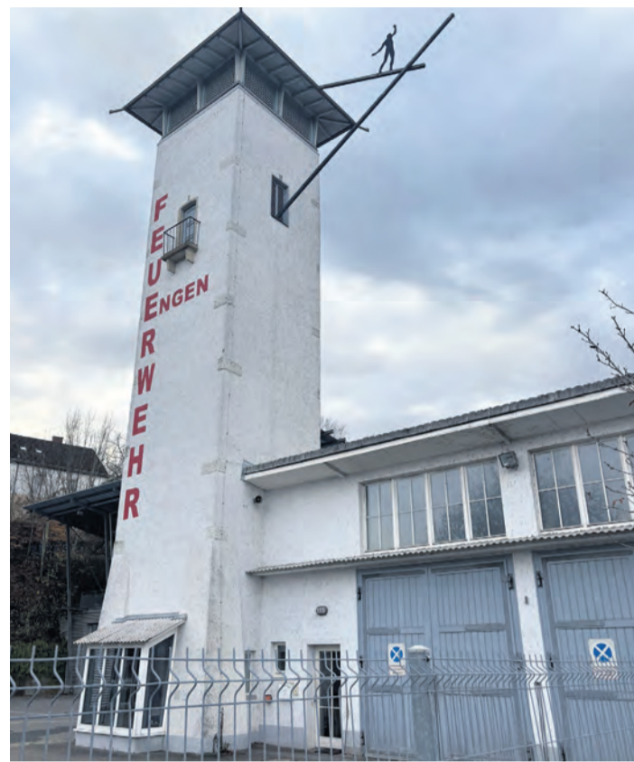
Die Tage des Feuerwehrgebäudes mit dem markanten Turm sind gezählt. Er soll einem Neubau weichen, in dem dann auch die Wehr Anselfingen unterkommen soll. swb-Bild: Tobias Lange
