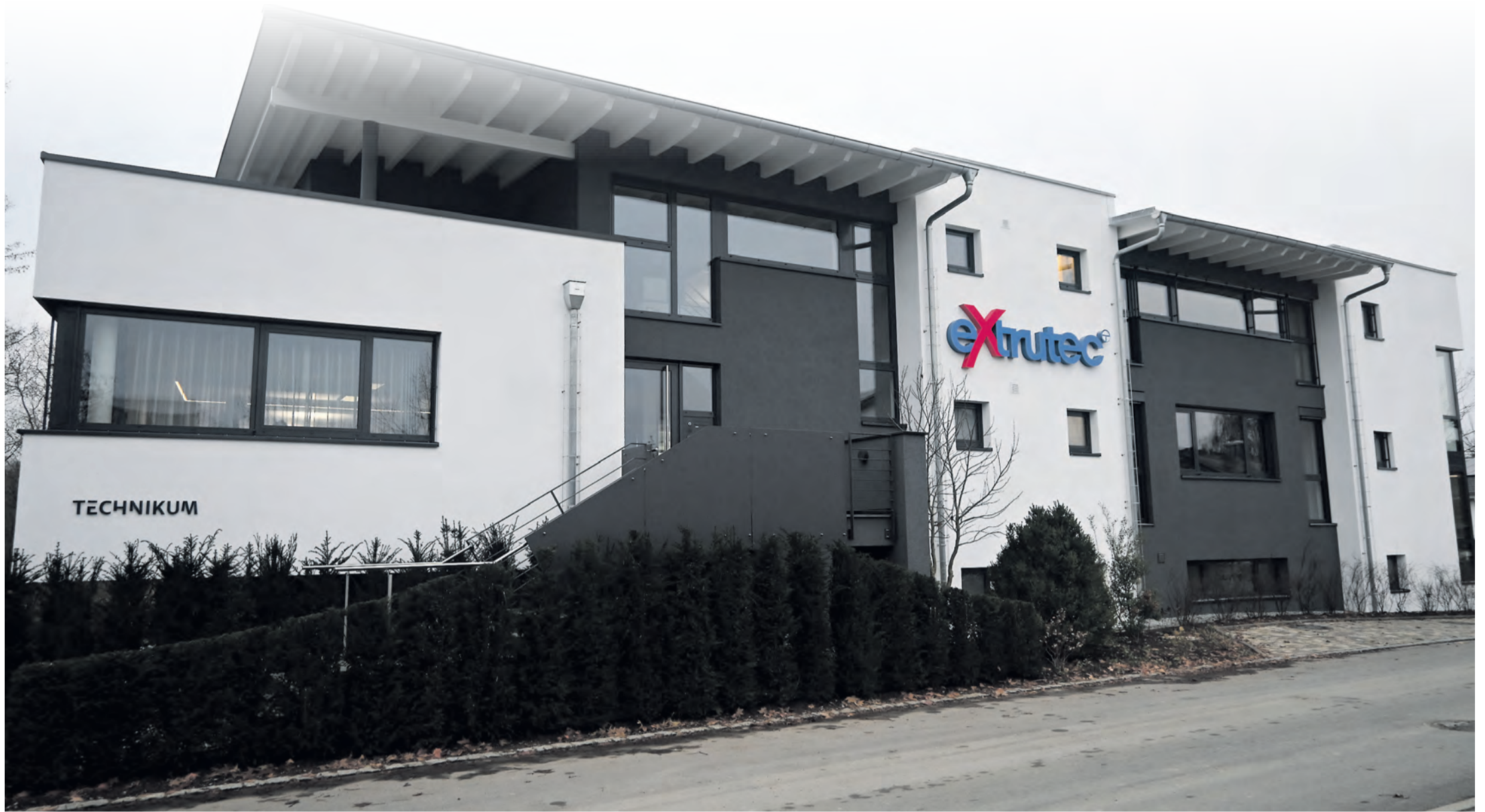
Der Neubau „Technikum“ bildet heute den zentralen Standort für alle technischen Bereiche des Unternehmens.
