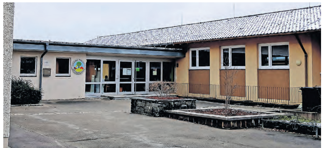
Das Projekt zur Sanierung der Eduard-Presser-Grundschule in Riedheim kann endlich realisiert werden. swb-Bild: Philipp Findling
