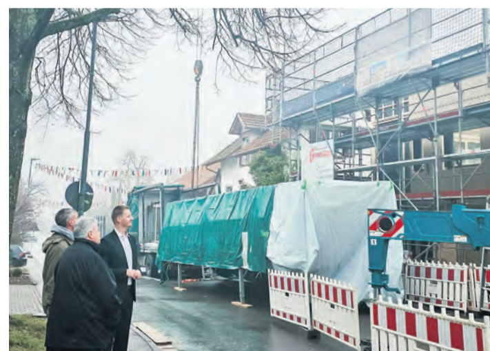
Blick auf die Baustelle: Ortsvorsteher Marc Rehm (von links), Ralf Mayer, Ortsvorsteher Möggingen a.D. und Oberbürgermeister Simon Gröger bei der Stellung der Holzständerwände.
