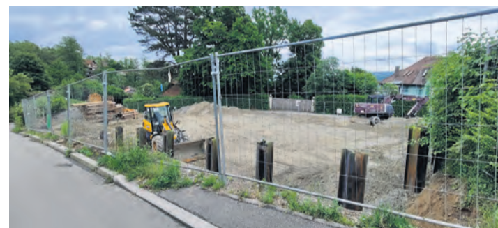
Die Baustelle gegenüber des Hesse-Hauses. Hier sollen zehn neue Wohnungen geschaffen werden. sub-Bild: Anja Kurz
